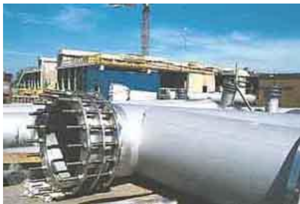
Seewasserwerk Frasnacht im Bau
